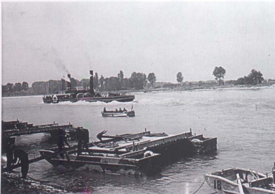
Hier werden 4 t-Fähren mit Zusatzgerät zusammgebaut. Die Pontons sind mit dem Dreifarben-Tarnanstrich versehen. Fähren mit Zusatzgerät wurden für Pontonbrücken verwendet, wenn der zu überbrückende Fluß eine hohe Stromgeschwindigkeit hatte. Durch den größeren Abstand von Ponton zu Ponton wurde der Brückenwiderstand verringert. (RF)
