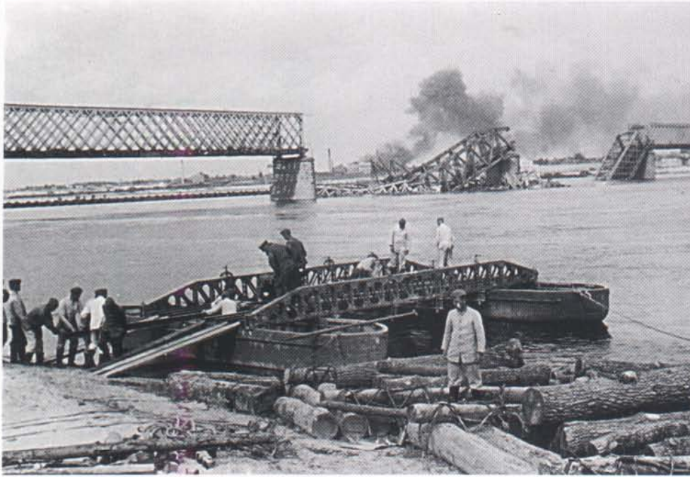
Die Bildbeschreibung lautet: "Kremenschug Eisenbahnbrücke nach der Sprengung. Darunter unsere Pontonbrücke". (RF) Die Pontons im Vordergrund sind weder dem A- noch dem T-Gerät zuzuordnen. Die zwischen den Pontons eingebauten Träger sind unbekannt.
