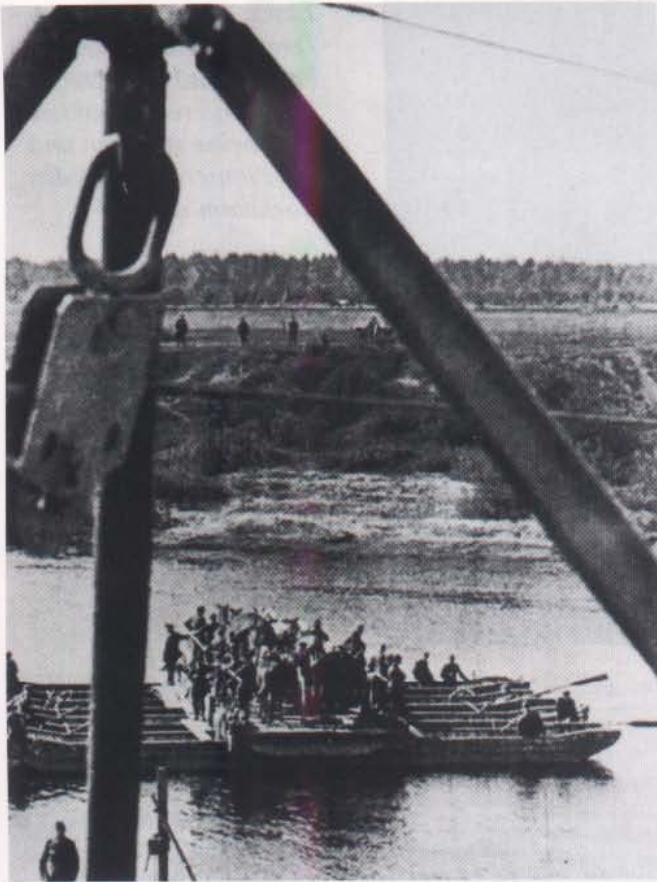
16 t-Fähre nach Ablegen von der Landbrücke durch Rudern in Gier-Stellung gebracht, wird - am Fährseil hängend - von der Strömung über den Fluß gedrückt. Vorn das über eine Rolle laufende, fest verankerte Fährseil. (Rußlandfeldzug) (PS)
