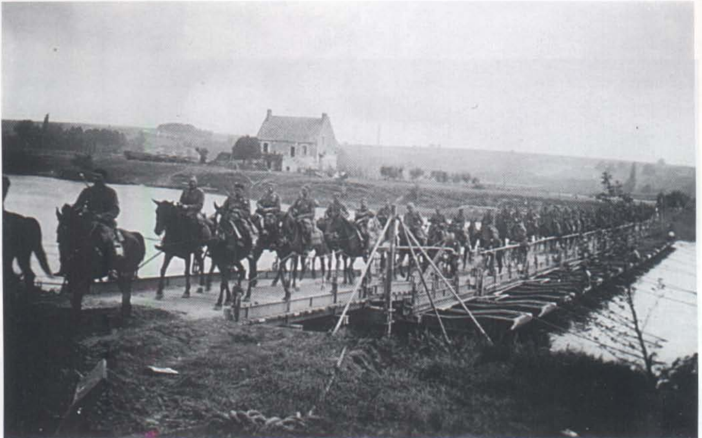
Eine Reiterschwadron auf einer 8 t-Pontonbrücke aus B-Gerät auf dem Vormarsch in Rußland.
