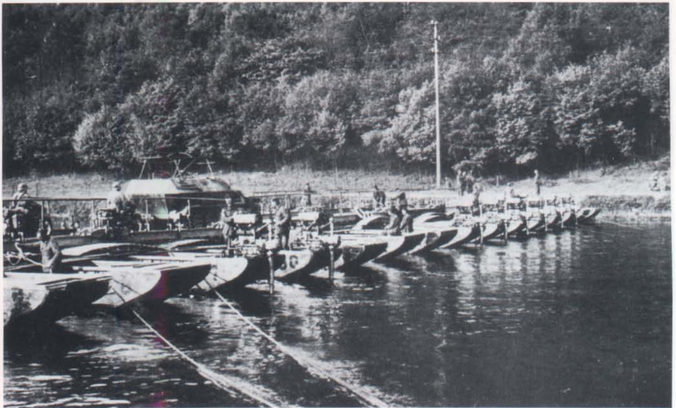
Eine 16-t-Brücke über die Maan, erbaut von deutschen Pionieren während des Feldzuges gegen Frankreich, 1940.
