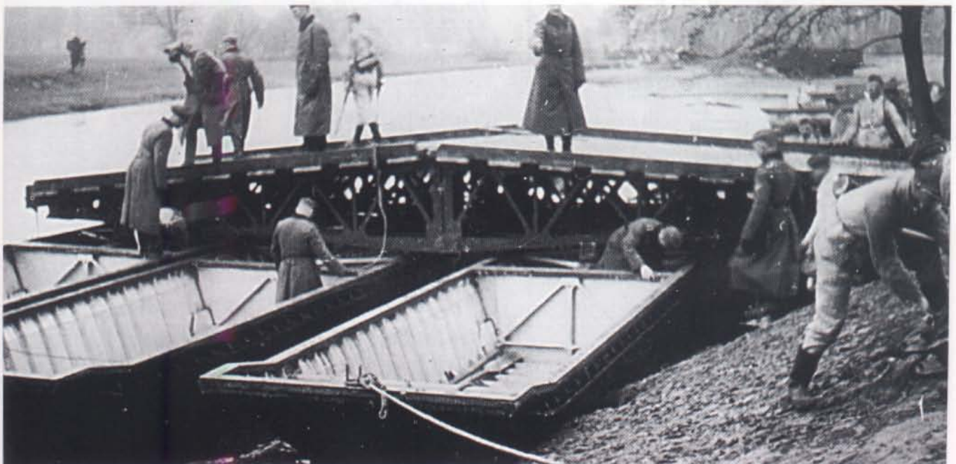
Eine kurze 16 t-Fähre wird zusammgebaut. 3 Pontons, bestehend aus 2 End- und 1 Mittelstück, sind fertig. Die Trägerendstücke liegen auf dem Pontonmittelstück. (RF)
