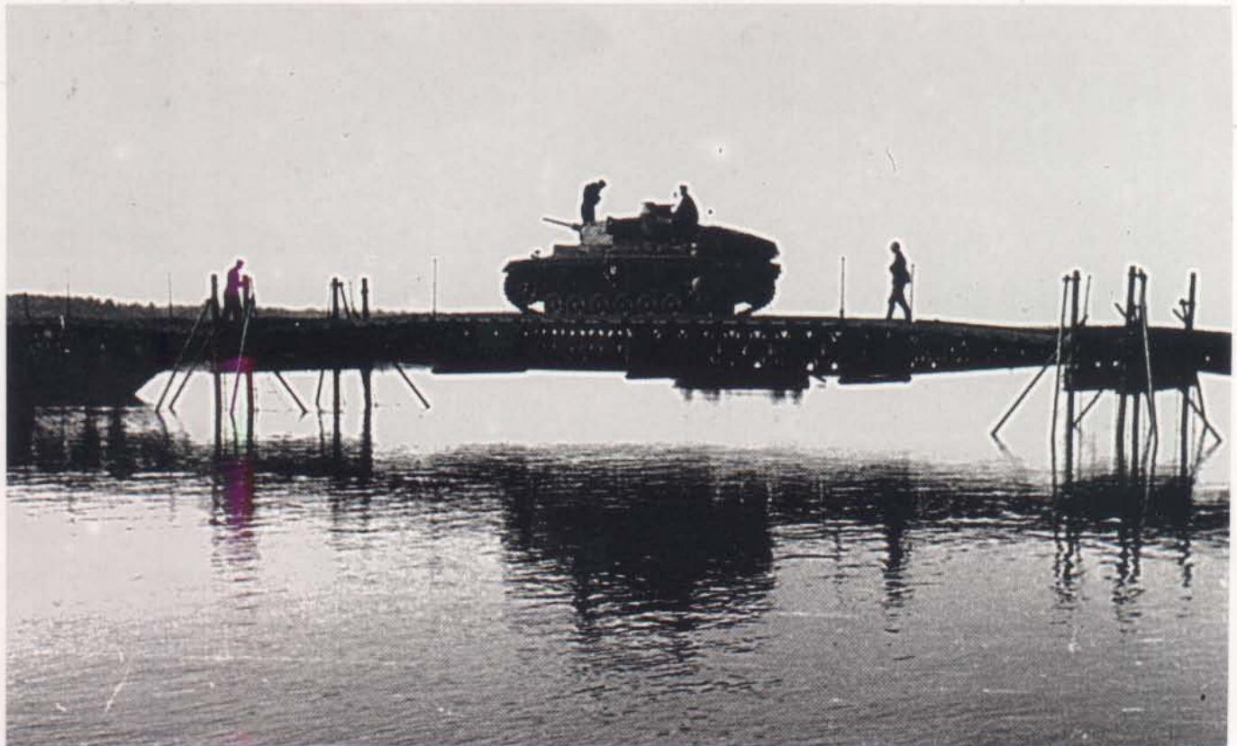
Vom Pz. Pi. Btl. 49 wurde eine Brücke mit doppeltem Bock über die Beresina aus K-Gerät gebaut. (RF)
