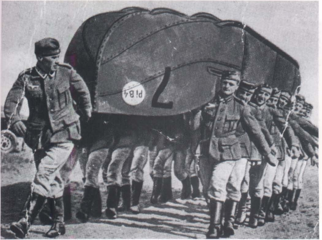
Ponton Nr. 7 vom Pionier-Bataillon 4, Magdeburg, wird ans Wasser getragen. Hierfür waren 1 Unteroffizier und 20 Mann erforderlich.
