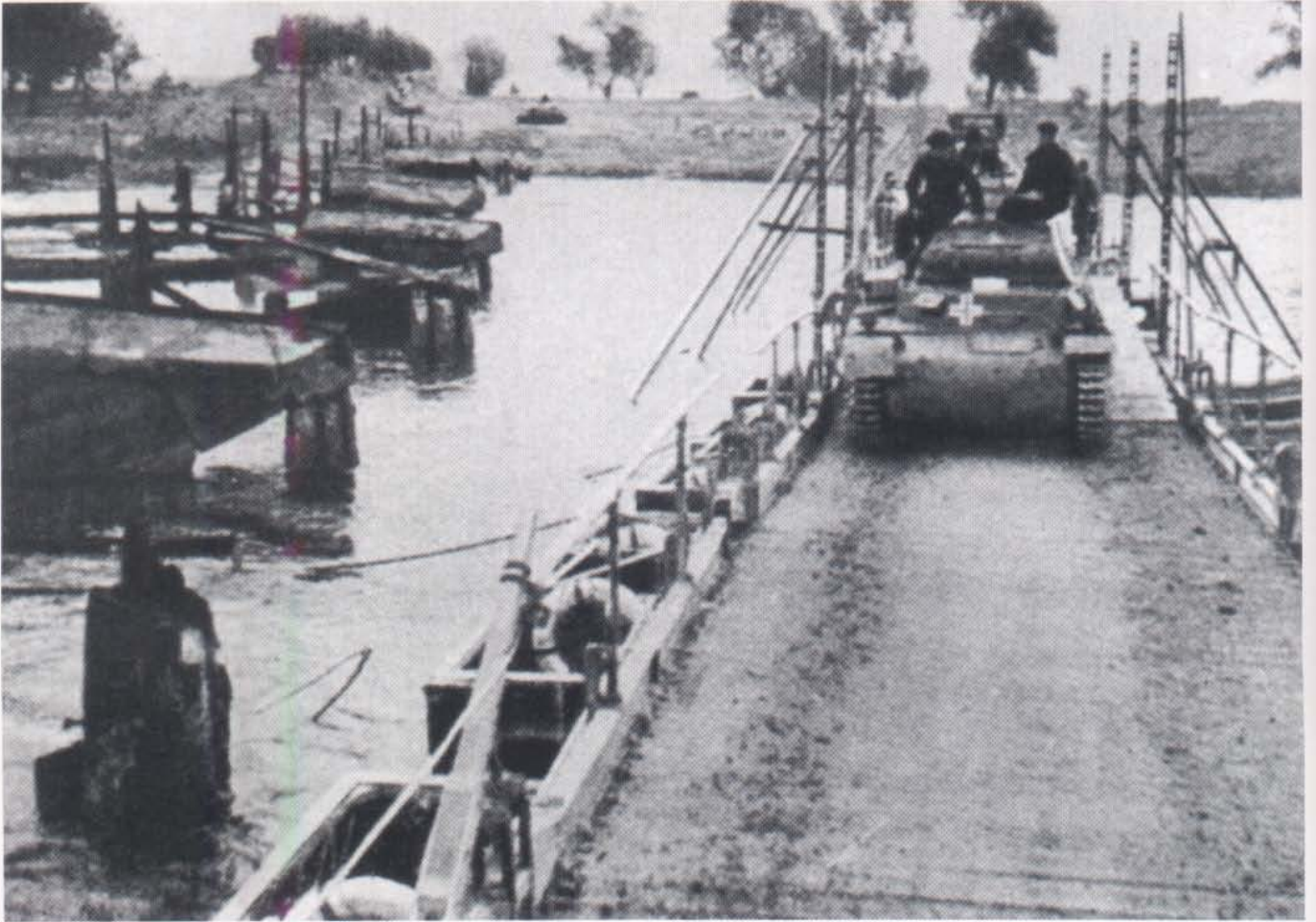
Eine 8 t-Ponton-Brücke mit einer landseitigen Bockstrecke aus B-Gerät ist fertiggestellt, nun können die Panzer rollen. (PS)
