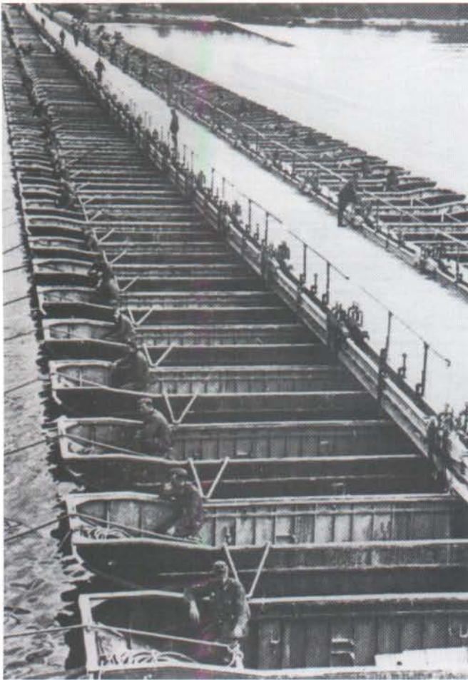
Oben: Dnjepr-Übergang über eine 8 t-Pontonbrücke bei Bereslaw. Vom Ufer ist eine Bockstrecke mit 3 Böcken gesetzt. Die Pontonbrücke liegt tiefer und wurde mit der Bockstrecke durch eine Rampe verbunden. Die Rampenteile wurden bei der Brückenkolonne im Ergänzungszug auf dem Rampenwagen mitgeführt. (PzP)
