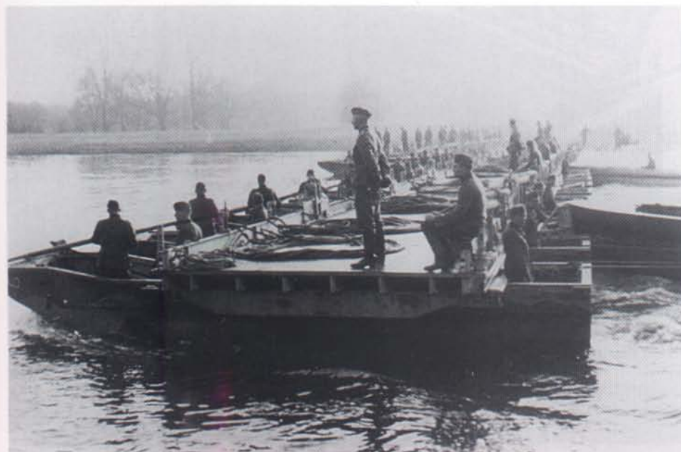
Übung des Pi-Lehr-Btl. 1 im Sommer 1939 an der Donau. Eine 8 t-Ponton- brücke im Bau. Gut erkenn- bar die auf den Halb- pontons liegenden 8 Streck- träger, darunter der Unter- zug. Ein einfacher Belag aus Belagbohlen bildet die Fahrbahn. Für eine 16 t- Brücke waren erforderlich Ganz-Pontons, 12 Streck- träger und doppelter Belag. (RK)
