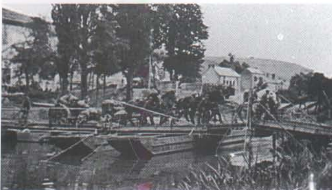
Links: Rohrwagen der s. F. H. 18 beim Übergang über die Marne auf einer 16 t-Pontonbrücke. (PzP)
