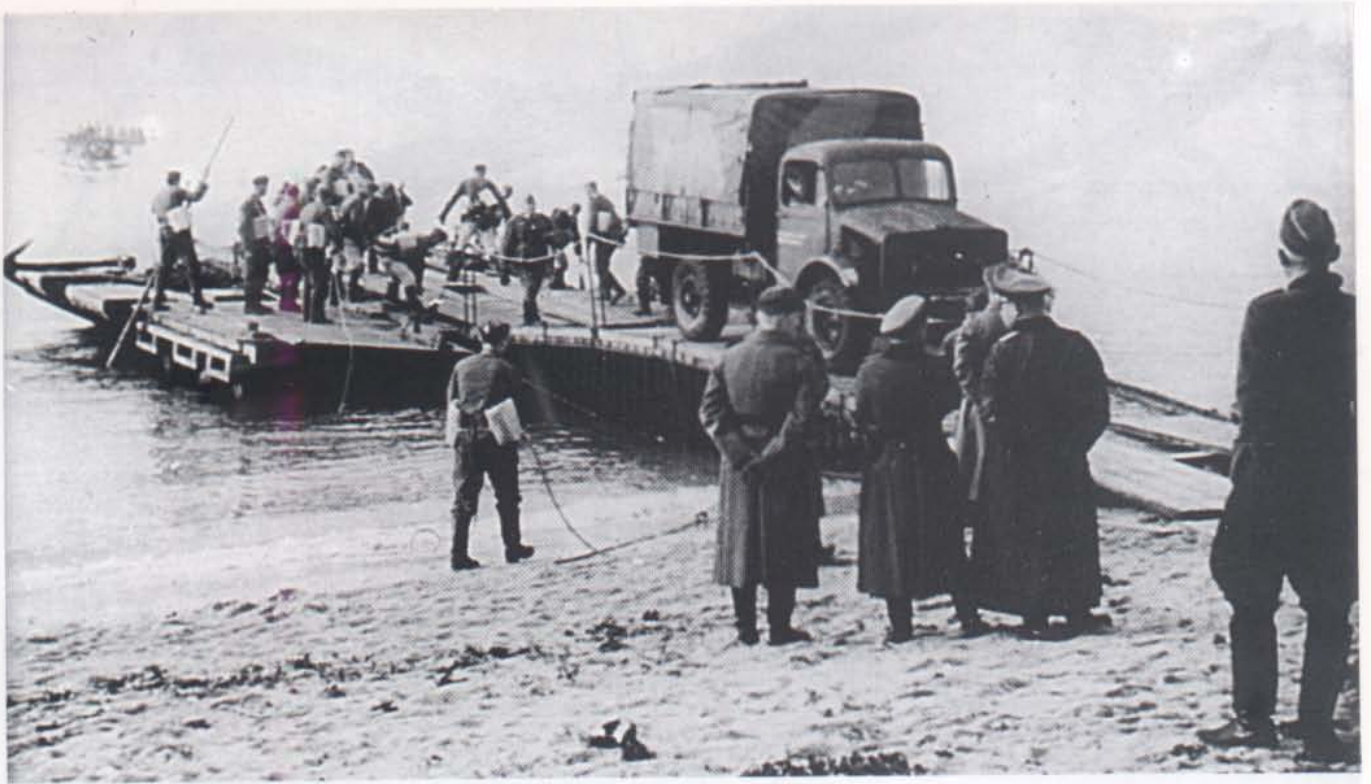
Oben: Eine Landbrücke aus K- Gerät als Anleger für B- Gerät-Fähren. (RK)
