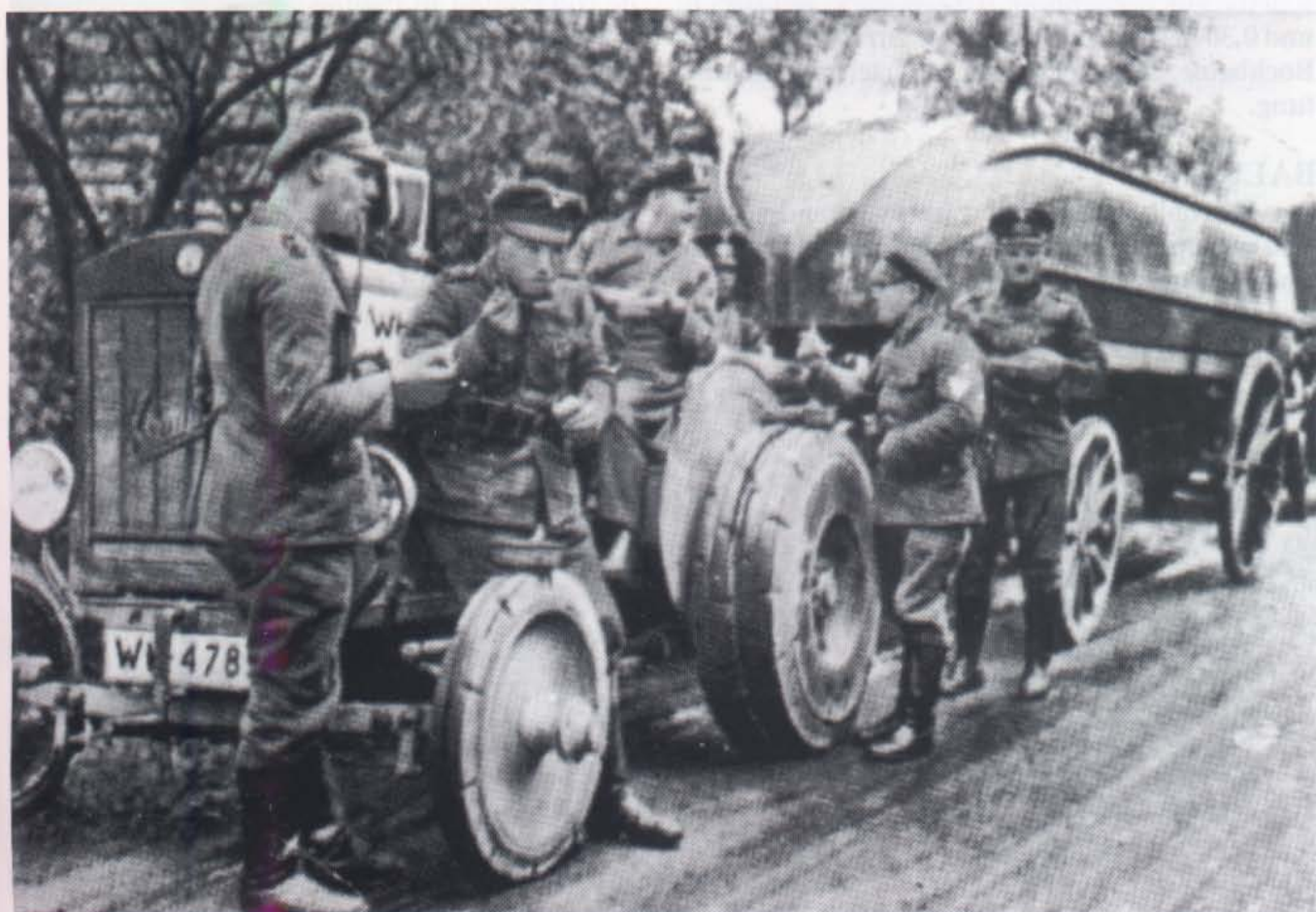
Eine Brückensäule während einer Marschpause. Der Pontonwagen für Pferdezug wurde behelfsmäßig motorisiert mit einem Komnik-Schlepper.
