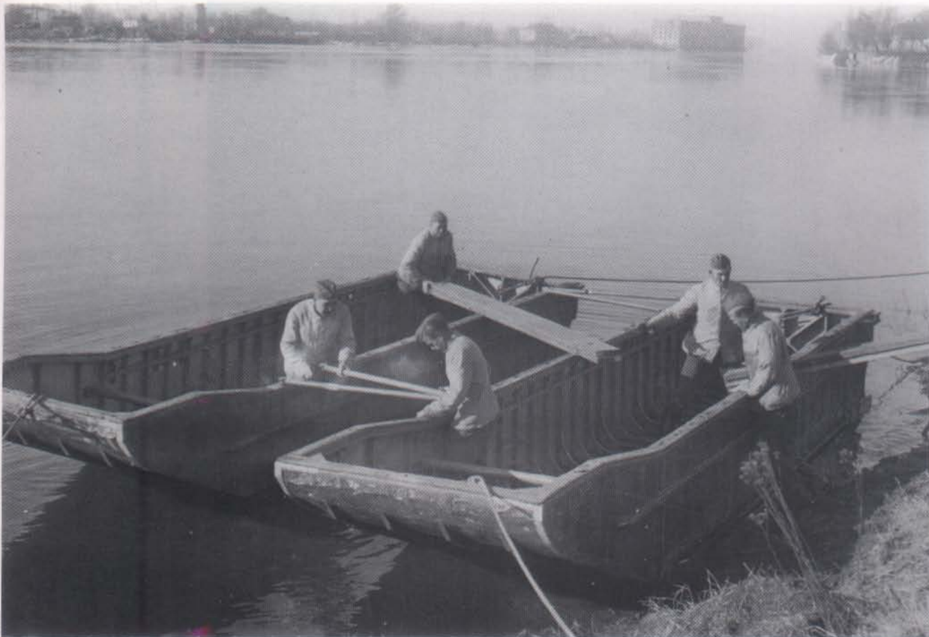
Fährenbau beim Pionier-Batl. 236 im März 1941 an der Weichsel. Die Pontons werden miteinander verbunden (RF).
