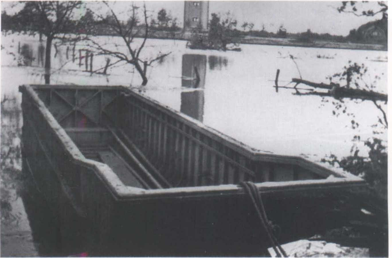
Ein Halbponton liegt im Wasser. Hier kann man einmal gut die Innenseite vom B-Ponton sehen. (PzP)
