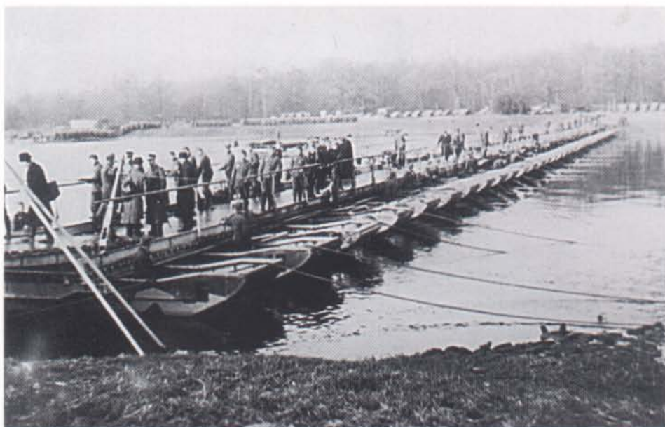
Übung des Pi-Lehr-Btl. 1 im Sommer 1939 an der Donau. Eine 8 t-Ponton- brücke im Bau. Gut erkenn- bar die auf den Halb- pontons liegenden 8 Streck- träger, darunter der Unter- zug. Ein einfacher Belag aus Belagbohlen bildet die Fahrbahn. Für eine 16 t- Brücke waren erforderlich Ganz-Pontons, 12 Streck- träger und doppelter Belag. (RK)
