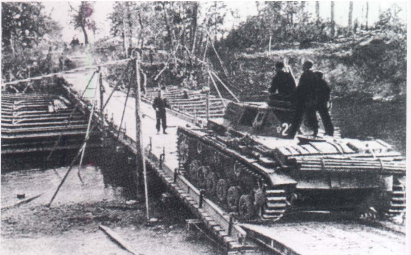
16 t-Ponton-Brücke aus B-Gerät mit einer Bockstrecke als Landbrücke, davor liegen Übergangsschienen. (PS)
