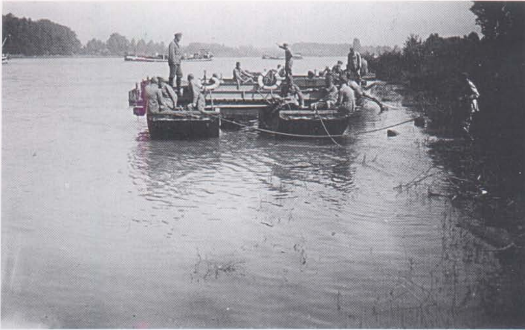
Die 4 t-Fähre ist fertig und kann eingesetzt werden (RF).
