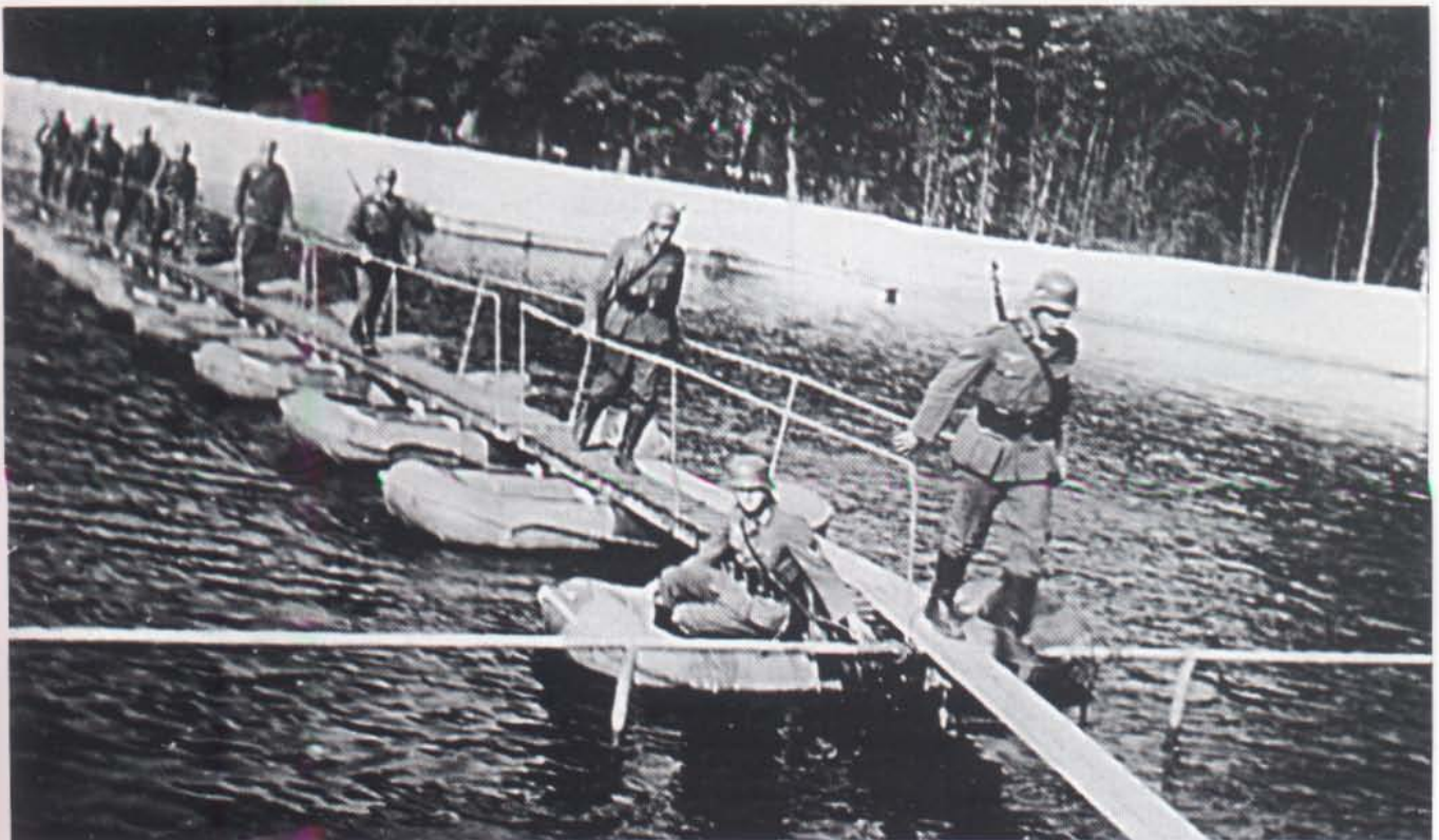
Ein Steg, gebaut aus kleinen Floßsäcken 34 und Brückentafeln des C-Gerätes, dient der Infanterie als Flußübergang. (RF)
