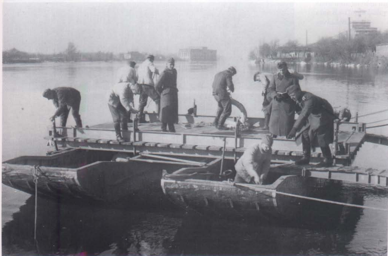
Eine 4 t-Fähre ist fast fertig montiert. Die Rodelträger werden befestigt. Als Verbindung zwischen Flußufer und Fähre wurden Übergangsschienen verlegt. (RF)
