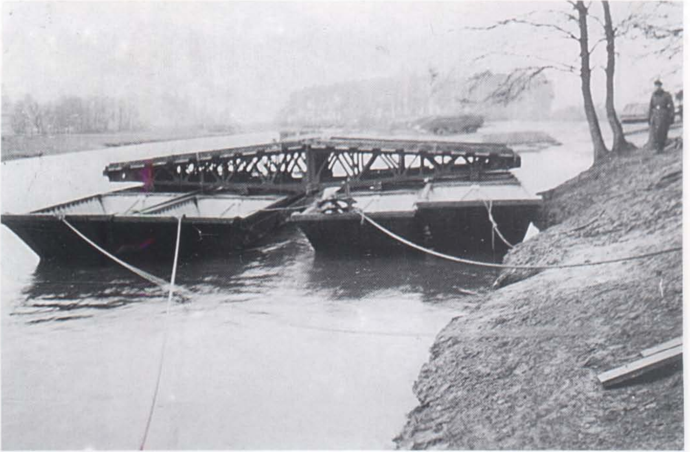
Das 4. Ponton ist angebaut und die Fähre ist fertig zum Einsatz. (RF)
