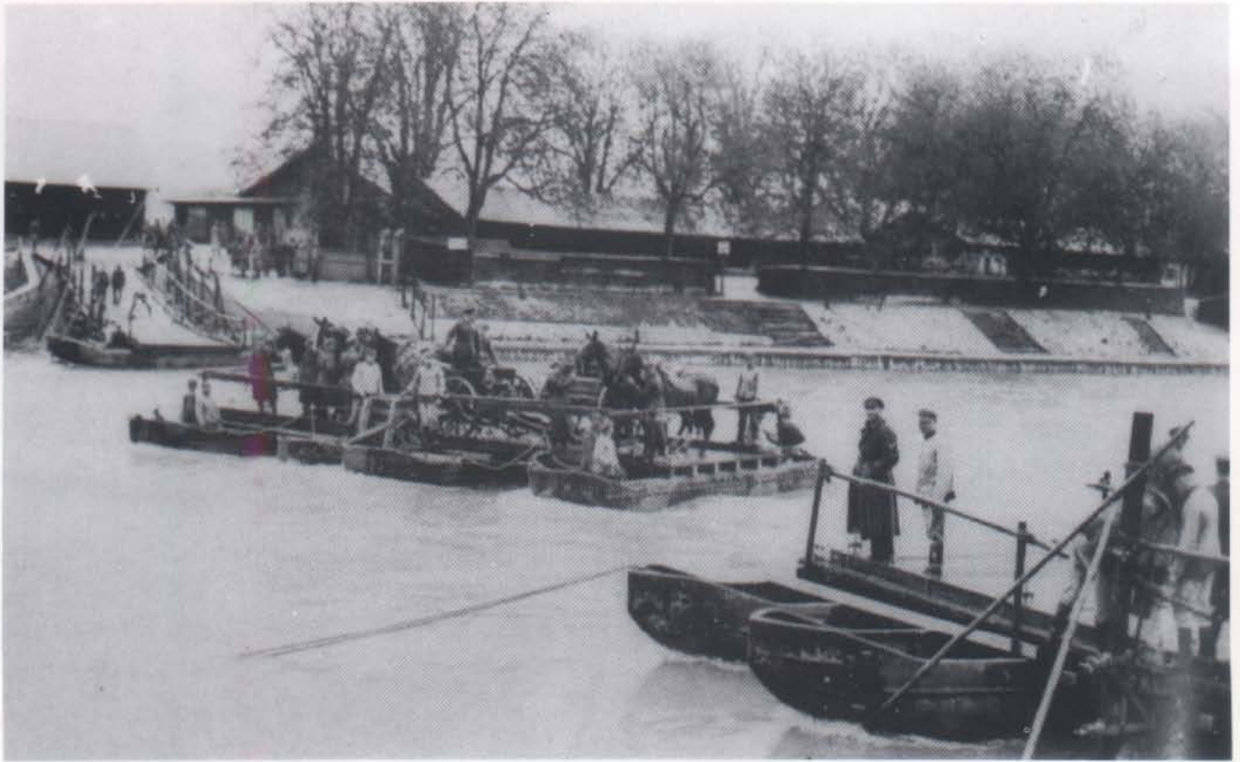
Eine Fähre an der Donau vom Pionier-Batl. 5, Ulm. Rechts unten sind vom Bock ein Bockbein mit den Bockstreben zu sehen. (PzP)
