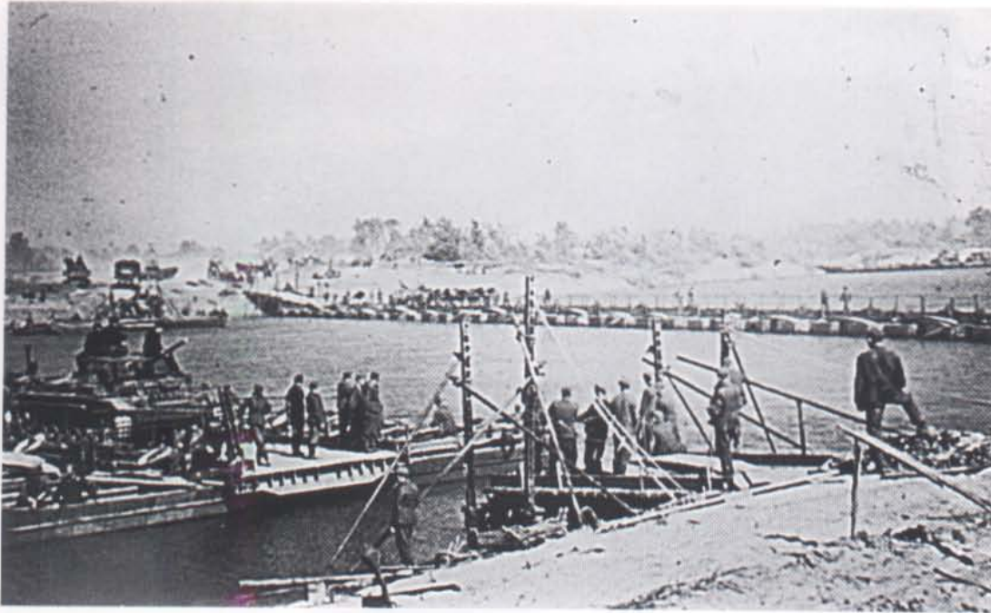
Auf einer 16 t-Fähre wurde ein Panzer III bei Potemkinskaja über den Don gesetzt (26. 7. 42). Die Fähre kurz vor dem Anlegen an der Landbrücke. (RK)
