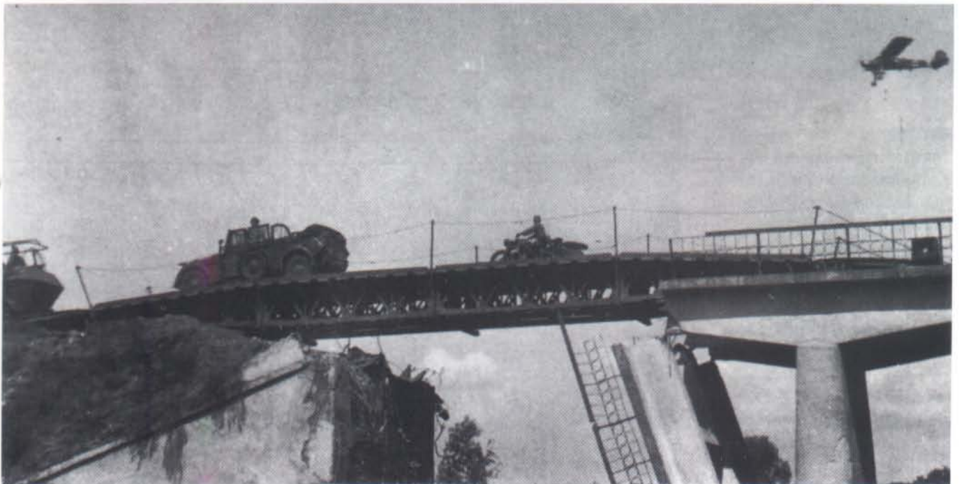
Die Ingulez-Brücke bei Kriwoi-Rog wurde von den Russen gesprengt. Vom Pz. Pi. Btl. 86 wurde die gesprengte Stelle mit K-Gerät überbrückt. (PzP)
