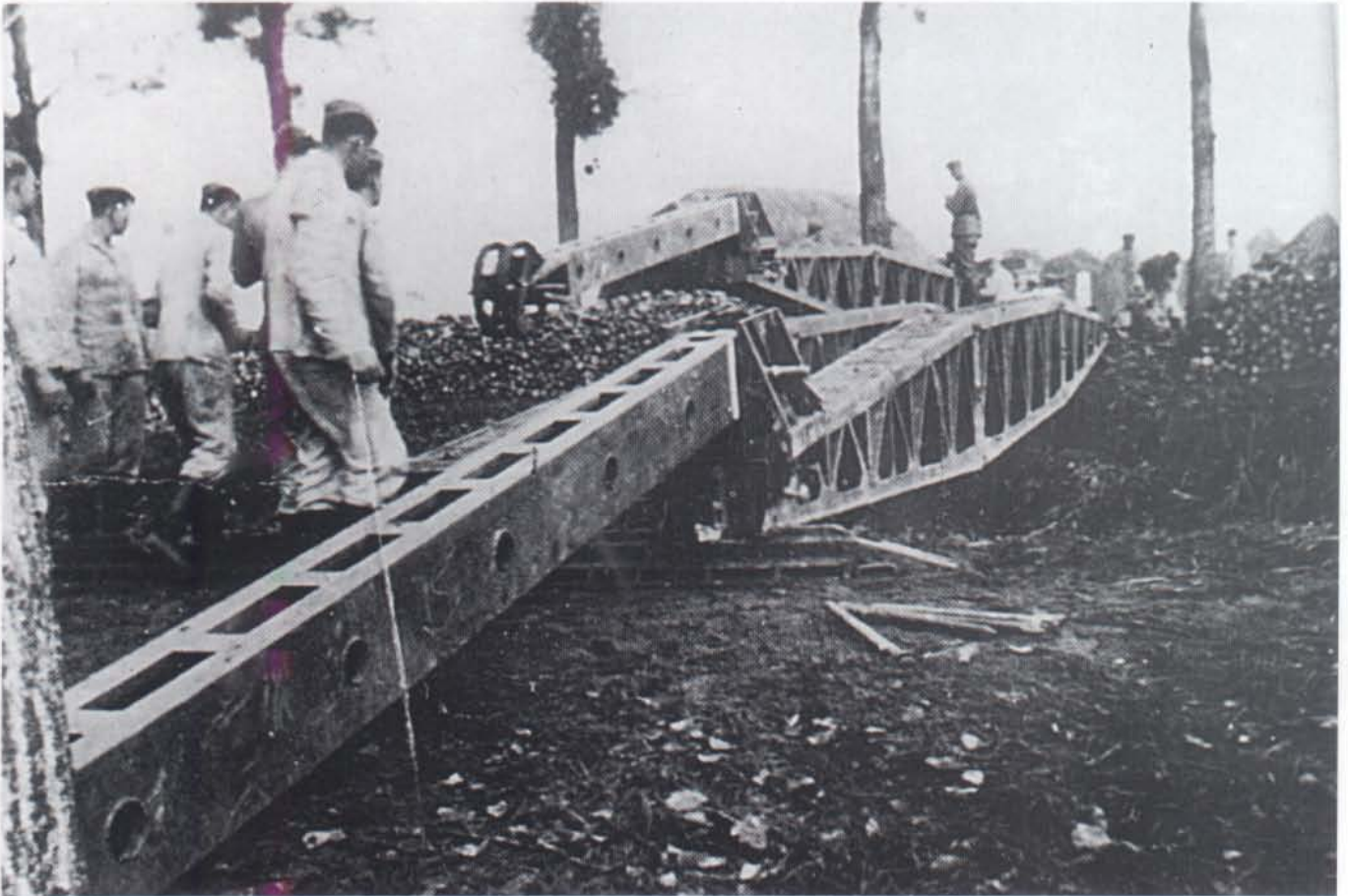
Pz. Pi. Btl. 1 der SS-Leibstandarte "A. H." bei der Ausbildung am K-Gerät durch Heerespioniere. August 1940. Gut zu erkennen sind Auslegerbock, Auslegerstück und Auslegerrolle am Trägerendstück. (RK)
