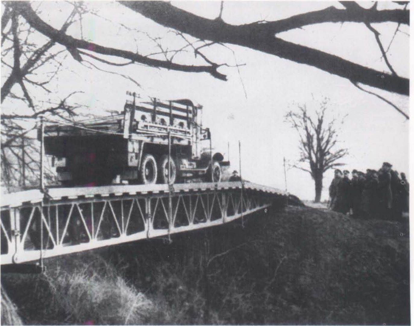
Die Brücke ist fertig. Mit einem m. gl. Lkw. wird die Belastungsprobe durchgeführt.
